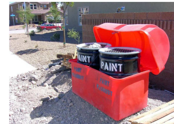
pintura correctamente almacenados
